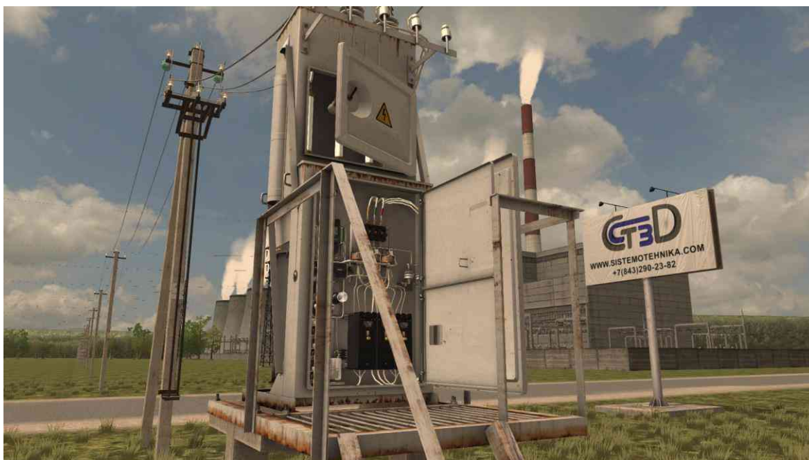
Рис. 17. Комплектная трансформаторная подстанция шкафного типа КТПС 10/0,4 кВ в среде СТЭлектро
