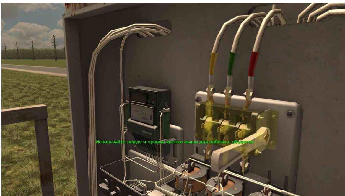
Рис. 18. Оперирование вводным рубильником РУНН комплектной трансформаторной подстанции шкафного типа КТПС 10/0,4 кВ в среде СТЭлектро
